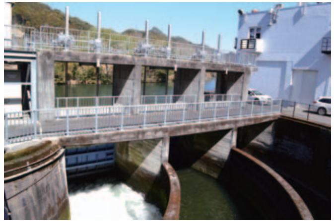
大野頭首工の取水口
