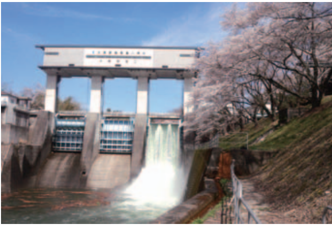
大野頭首工からの放流
