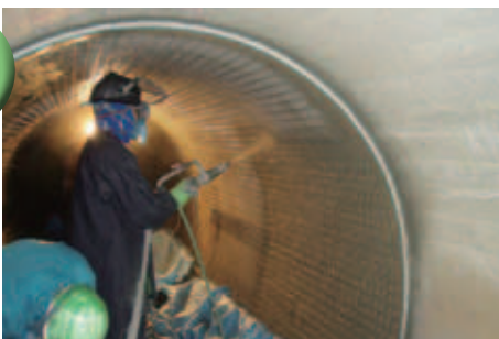
トンネル増厚吹き付け工事
