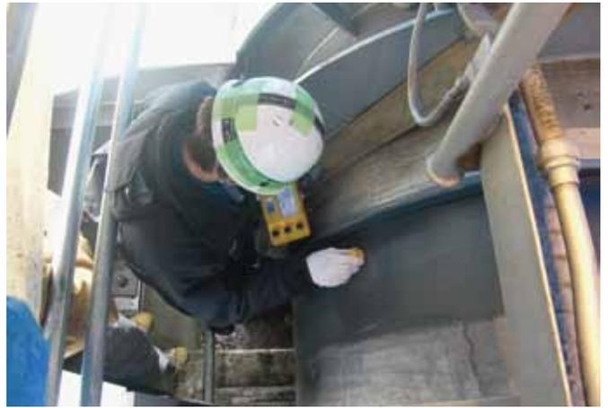
水管橋の塗膜厚の測定
