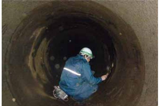
導水管(直径1.5m)内での塗装作業
