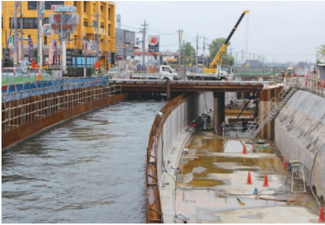
改築中の武蔵水路
