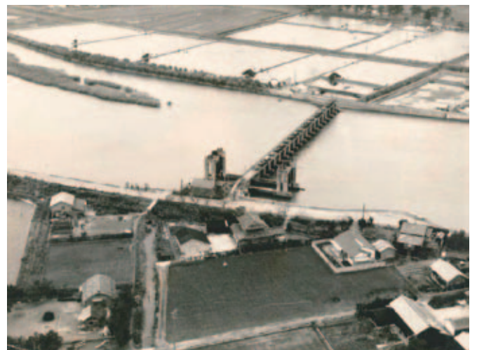
撤去される前の潮止樋門(旧吉野川)
