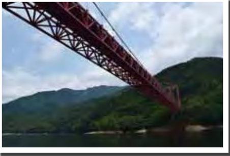
早明浦ダム湖面から上吉野川橋を見上げる
