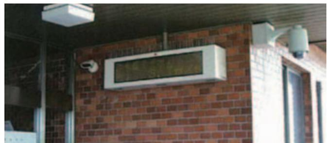
筑後大堰管理室玄関に設置された流下量掲示板
