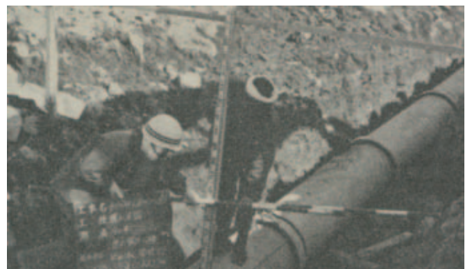
建設中の県営支線水路
