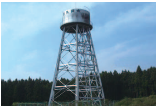
上之原高架水槽
