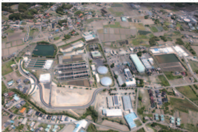
県企業局県央第一水道施設
