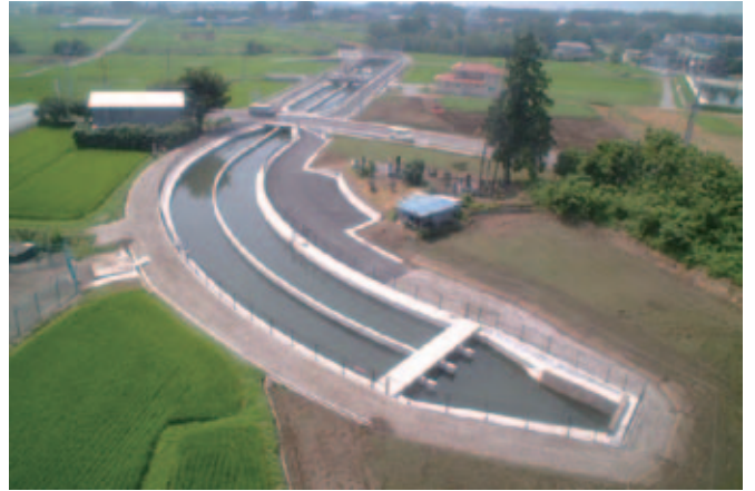
緊急改築事業で整備された二連水路
