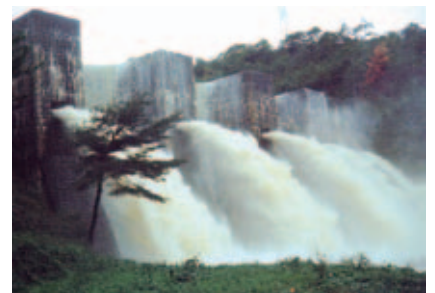
写真3 昭和初年に築造された豊稔池
