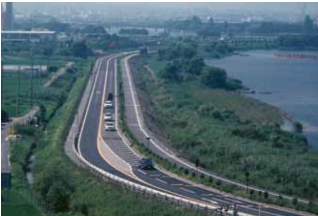
草津地区湖岸堤・管理用道路
