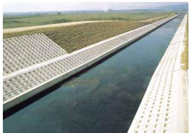
流入河川改修(南川、高島市)
