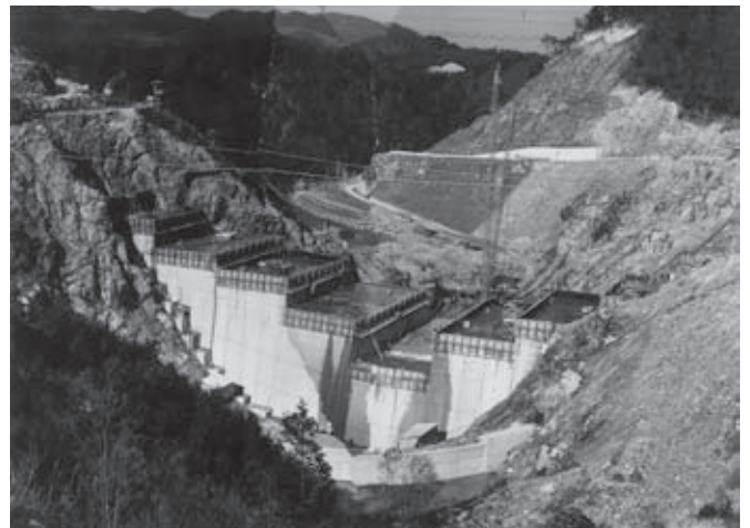
河川を横断するダム軸に対して、直角の継ぎ目のみのブロックに分けて施工する、柱状レヤ工法で施工中の室生ダム
