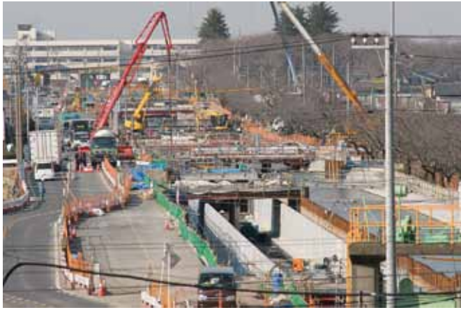
橋や道路を迂回させての工事
