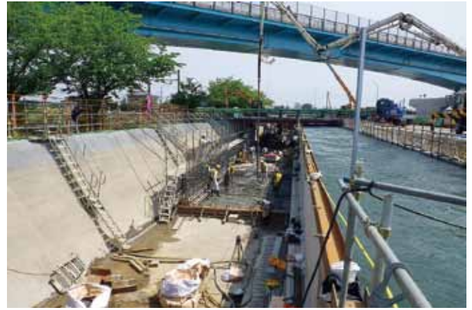
半断面ずつ進められる工事
