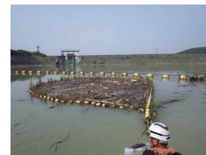
流木の回収(寺内ダム)
