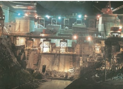
建設中の下久保ダム
