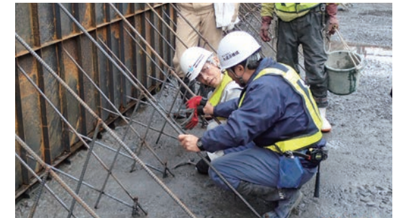
ダム本体工事施工監理
