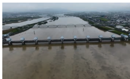
ゲートを河川堤防より高く引き上げて、洪水を安全に流下させる長良川河口堰
