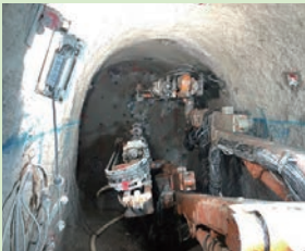
水路トンネル工事
