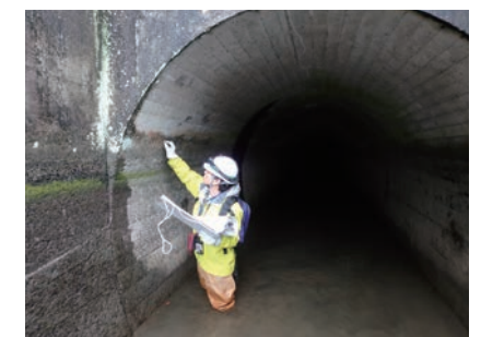
水路トンネルの点検(両筑平野用水)
