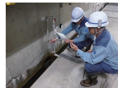
堤体内の漏水量測定(大山ダム)
