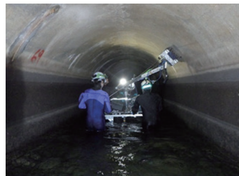
(左:通水点検装置車による背面画像撮影、右:通水台車による背面空洞調査) ICT等新技術を活用した機能診断調査(香川用水)
