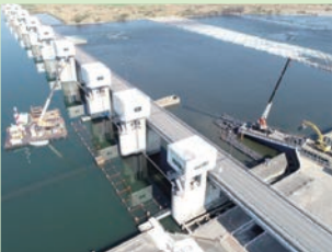
耐震補強工事中の利根大堰
