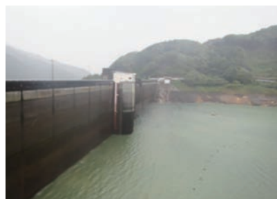
事前放流後の貯水池(草木ダム)
