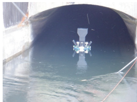
(左:通水点検装置車による背面画像撮影、右:通水台車による背面空洞調査) ICT等新技術を活用した機能診断調査(香川用水)
