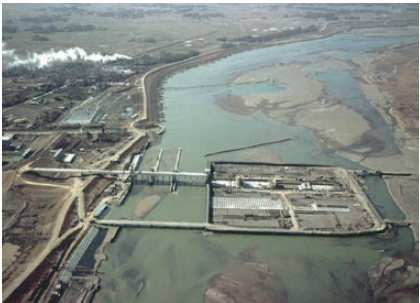
建設中の利根大堰
