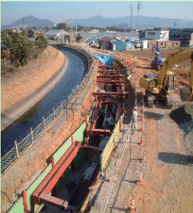
併設水路工事
