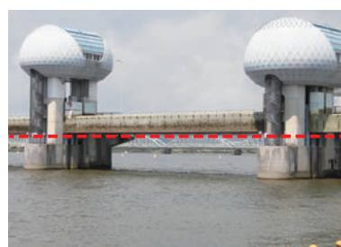
ゲートを河川堤防より高く引き上げて、洪水を安全に流下させる長良川河口堰
