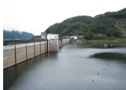
洪水前の貯水池(草木ダム)
