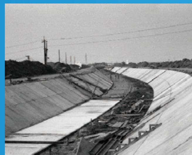
●武蔵水路の工事風景(水資源機構資料より)
