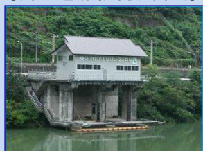
【取水口上屋(群馬用水綾戸取水口)】
