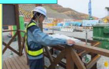
工事監督(現場確認)
