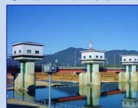
【堰上屋(豊川用水牟呂松原頭首工)】
