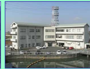
【水路管理棟(筑後川下流用水)】
