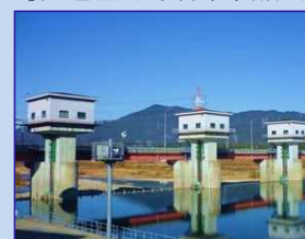
【堰上屋(豊川用水牟呂松原頭首工)】
