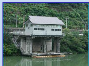
【取水口上屋(群馬用水綾戸取水口)】
