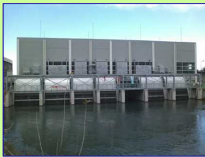
【排水機場(武蔵水路糠田機場)】
