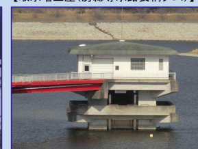
【取水塔上屋(房総導水路長柄ダム)】
