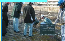
行政中間検査(2階配筋完了)
