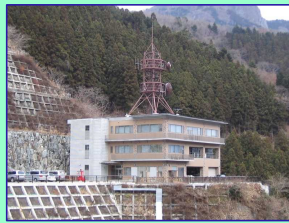
【ダム管理棟(滝沢ダム)】
