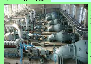
改修を控えた糠田第二排水機場
