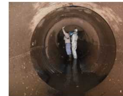
従来の機能診断調査 (空水にしたうえでの内部調査)
