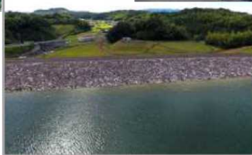
< UAVを活用した調整池の巡視点検 >
