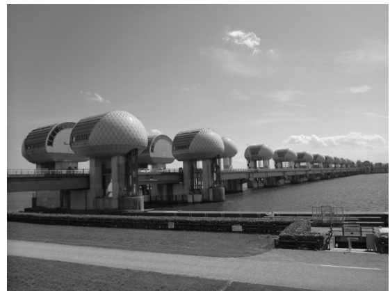
写真-1 長良川河口堰
