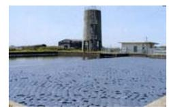
図-9 高濁度取水モード図 図-10 遮光対策の例
