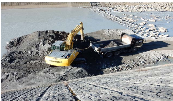
写真-4 火山噴出物撤去状況 (平成27年2月4日)
