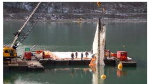
写真-3 沈下式汚濁防止フェンス
