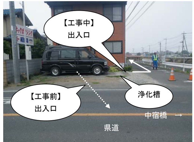
写真-5 浄化槽補強工事箇所の状況
