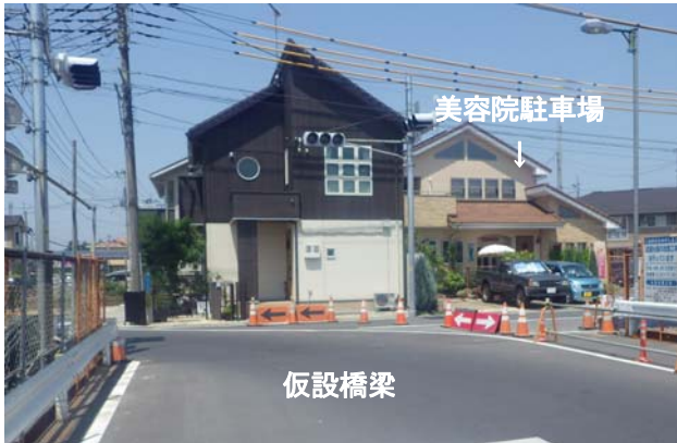
写真-3 仮設橋梁と美容院駐車場の位置関係
