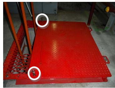
写真-9 蝶ボルトによる締め込み
