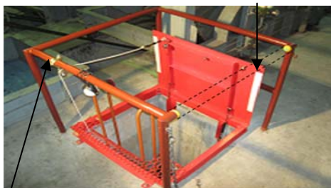
移設後のガードパイプとクランプ滑車
