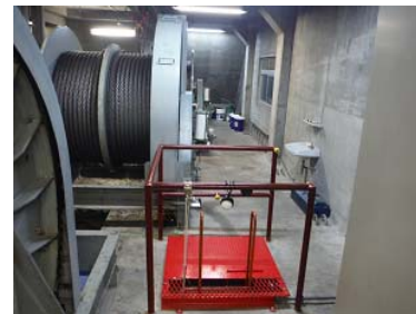
写真-10 鋼製蓋の全景
