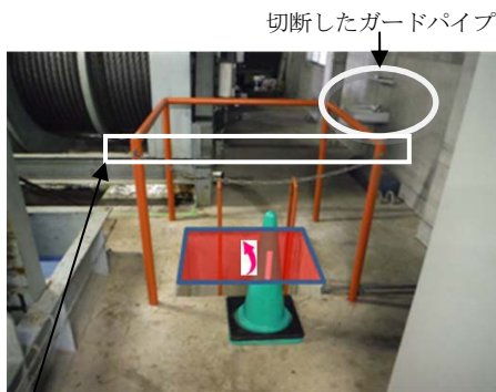
切断したガードパイプを移設した箇所
