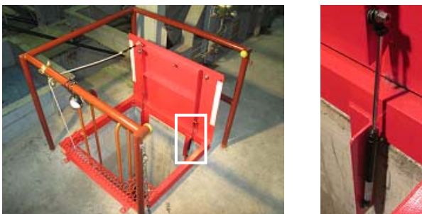
写真-3 ガススプリングによる開閉補助
