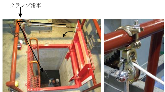
写真-4 クランプ滑車による閉作業
