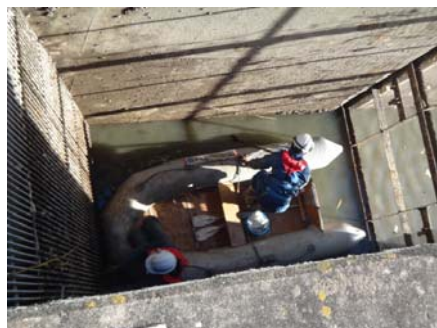
写真-3 スクリーンの除去状況
