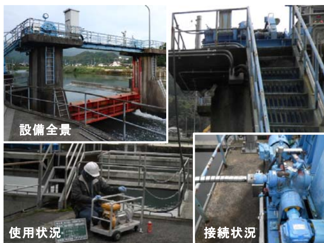
写真-1 可搬式シャフト開閉機使用状況
