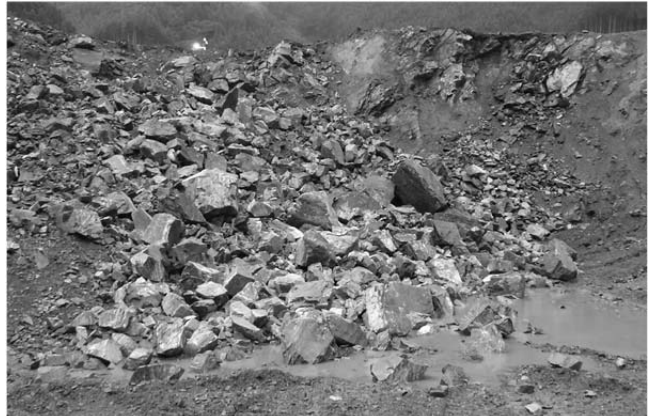
写真ー1 発破後の切羽の外観（岩種判別が困難な例）
