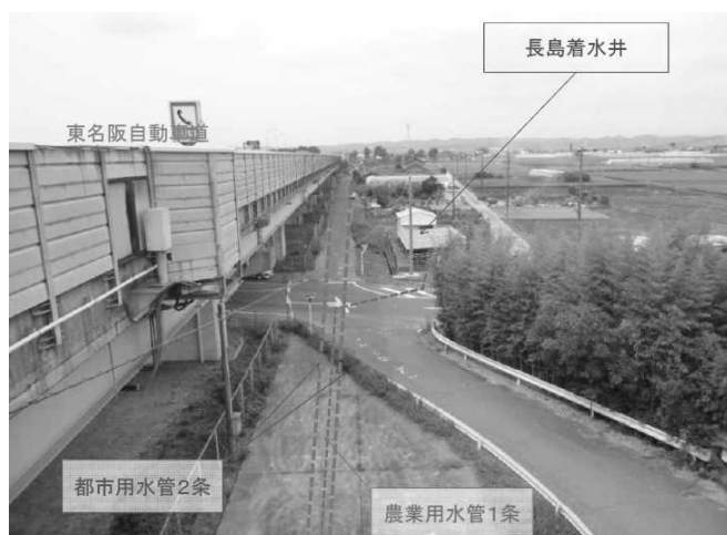
図-3 長島着水井周辺写真
