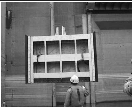
写真-1 補助取水ゲート更新状況
