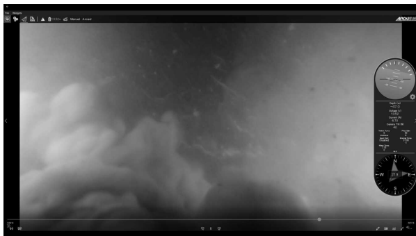
写真-4 水中 ROV による扉体周辺状況
