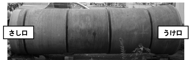
写真-2 PC管の全景
