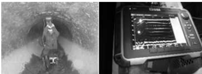
写真-3 電磁波レーダー探査法による調査状況
