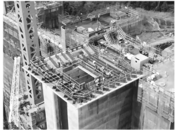
写真-2 堤頂張出部（取水設備）
