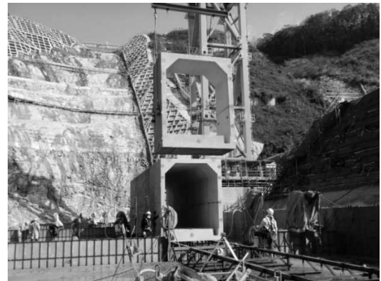
写真-5 PCa部材の据付状況
