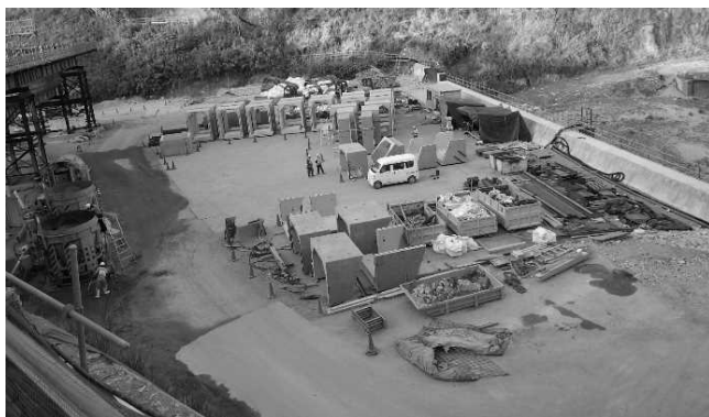
写真-3 PCa部材ストックヤード
