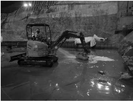
写真-7 グリーンカットマシンの活用状況
