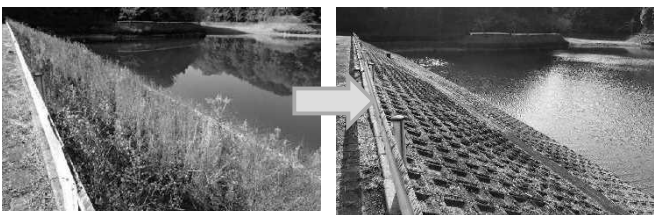
図-6 堤体上流法面状況と対策後状況
