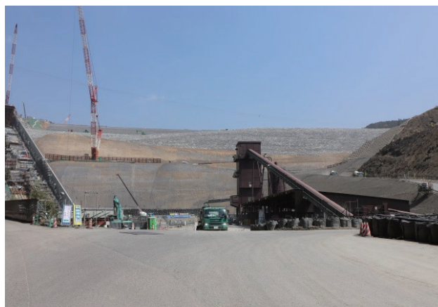
ダム本体盛立て（小石原川ダム建設事業）
