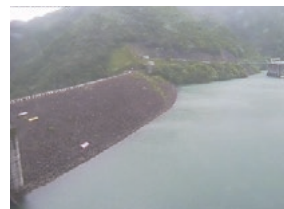
洪水貯留開始前の 岩屋ダム貯水池
