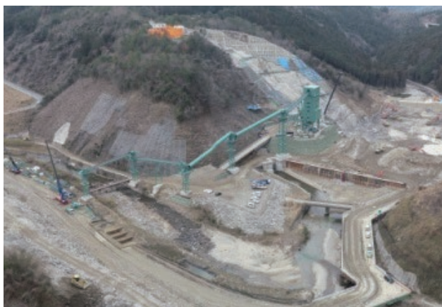
ダム本体工事（川上ダム建設事業）
