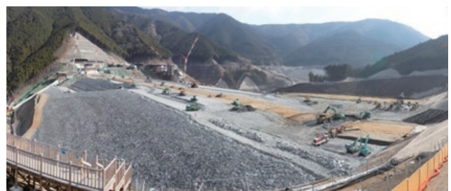
小石原川ダム建設事業（ダム本体工事）
