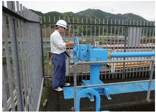
水路施設の点検（両筑平野用水）
