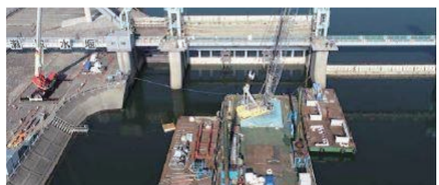
利根導水路大規模地震対策事業（秋ヶ瀬取水堰耐震補強）
