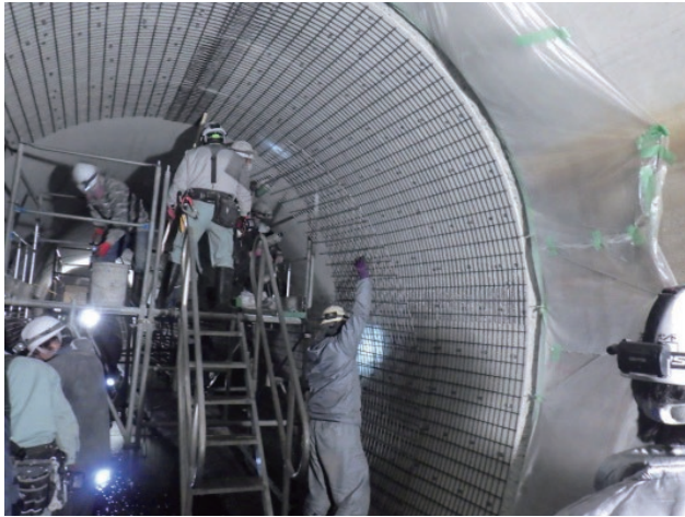
トンネル耐震補強 (房総導水路施設緊急改築事業)
