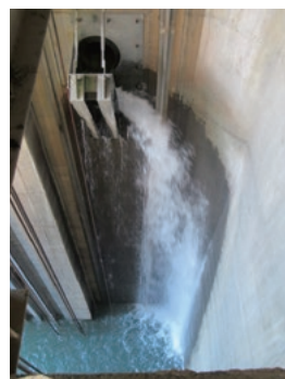
バイパス水路の吐出口
