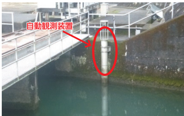
水質自動観測設備 (愛知用水)
