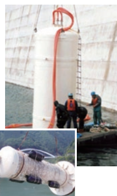
設備の設置状況
