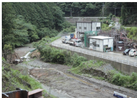
濁水プラント（小石原川ダム本体工事）
