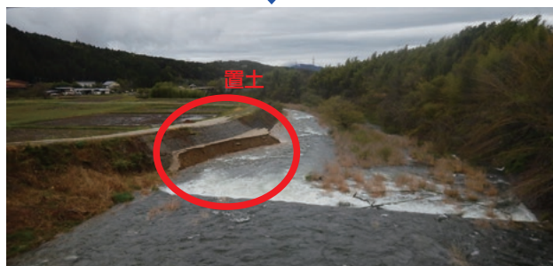
フラッシュ放流後 下流河川への土砂還元（阿木川ダム）
