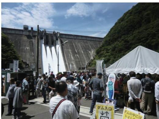
放流設備点検イベント（下久保ダム）
