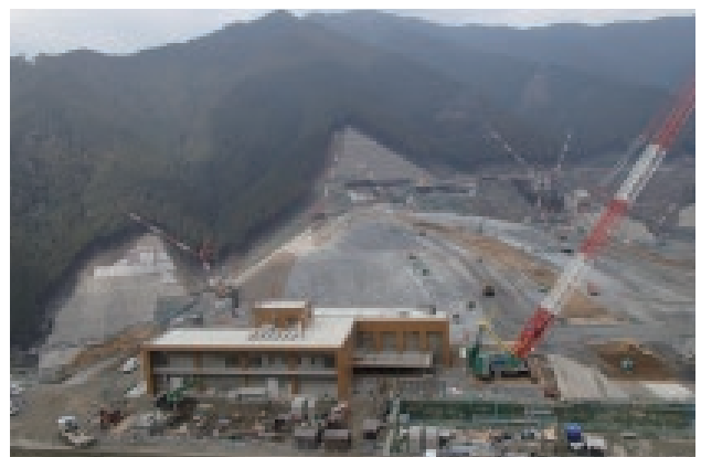
管理棟等の施工状況（平成 31 年 3 月時点）
