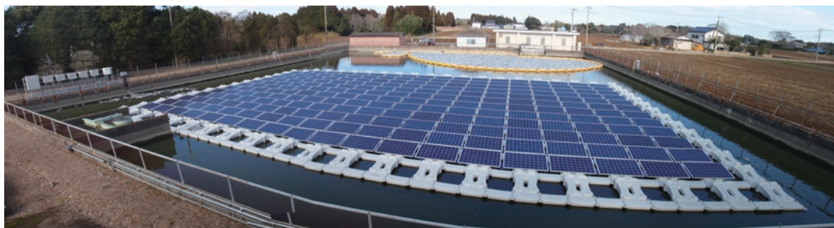
太陽光発電設備（北総東部用水）
