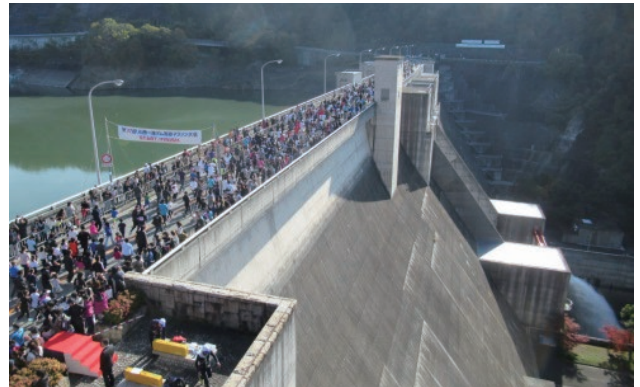
ダム周回道路を活用したマラソン大会（一庫ダム）
