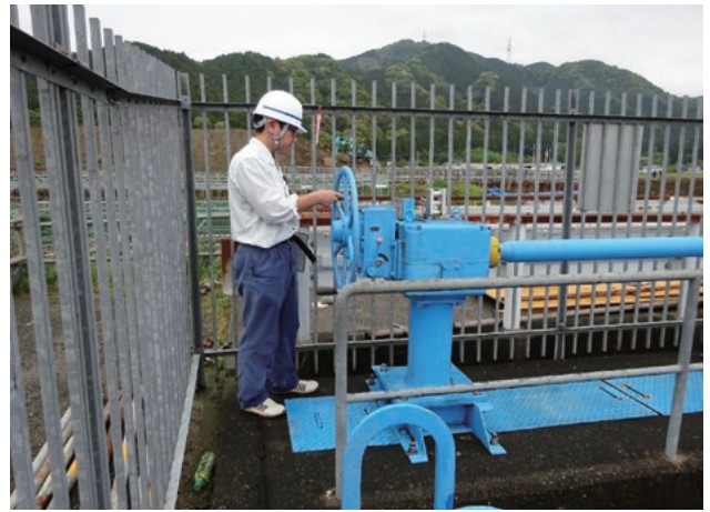
水路施設の点検（両筑平野用水）
