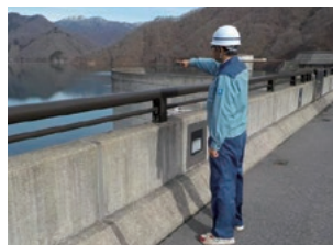
貯水池巡視（徳山ダム）
