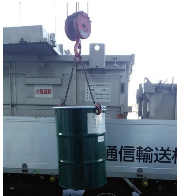
処分した PCB 廃棄物（千葉用水総合管理所）
