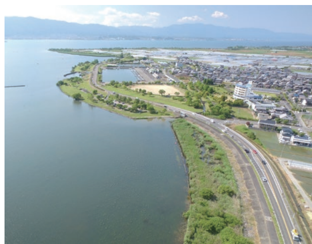
ヨシ植栽等を実施した前浜と湖岸堤 (草津市)
