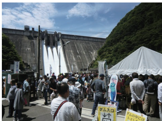
放流設備点検イベント（下久保ダム）
