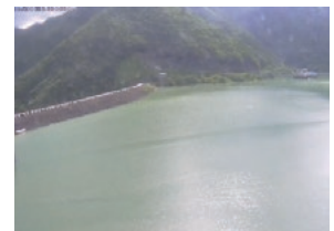
洪水時最高水位に近づく 岩屋ダム貯水池
