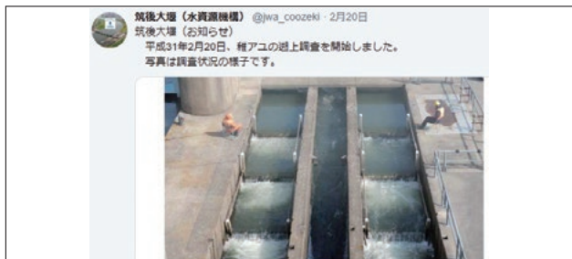
筑後大堰 稚アユの遡上調査開始
