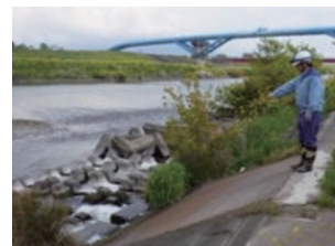
放流水の巡視（霞ヶ浦用水）
