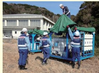
可搬式浄水装置設置状況
