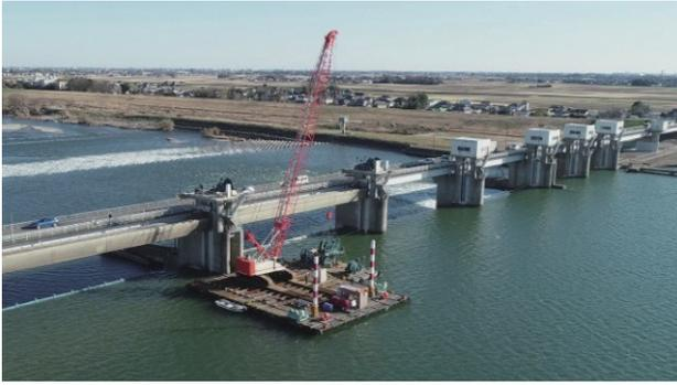
利根大堰耐震補強工事（利根導水路大規模地震対策事業）
