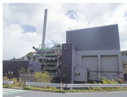
バイオマス発電施設
