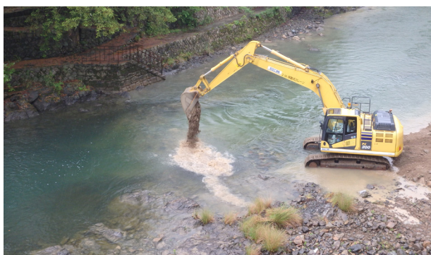
ダム直下における土砂投入状況
