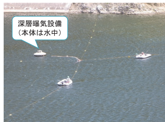
深層曝気設備の能力に関する現地調査(一庫ダム)
