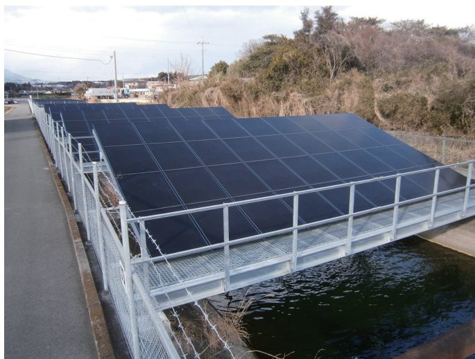
太陽光発電設備（群馬用水）
