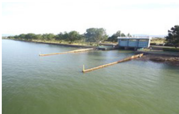
周辺環境との調和が図られた木杭による突堤（琵琶湖開発総合管理所）
