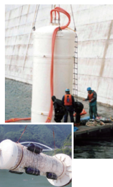
設備の設置状況
