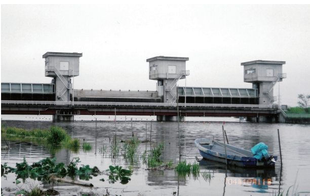
台風22号により水位上昇した霞ヶ浦 (新利根川河口水門付近)
