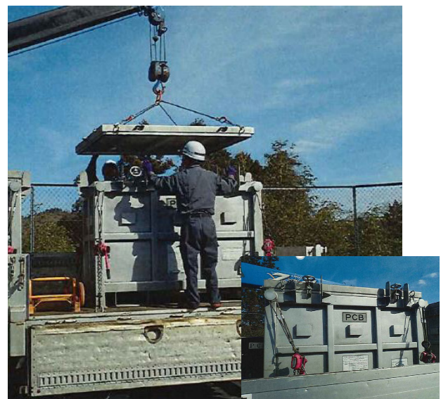
処分した PCB 廃棄物 (下久保ダム管理所)
