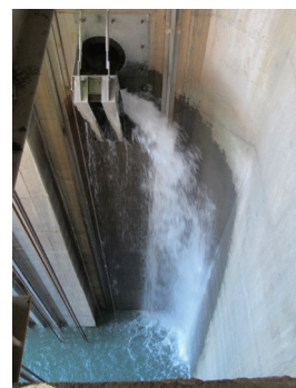
バイパス水路の吐出口
