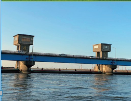
利根川河口堰
