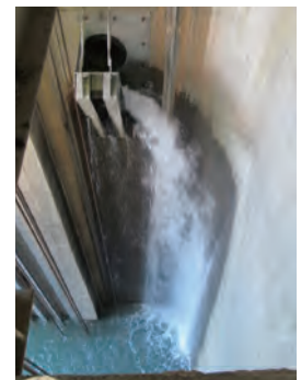
バイパス水路の吐出部
