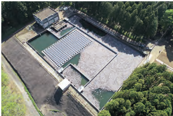
太陽光発電設備と六角フロート（成田用水（高田ファーム Pond）） ※4
