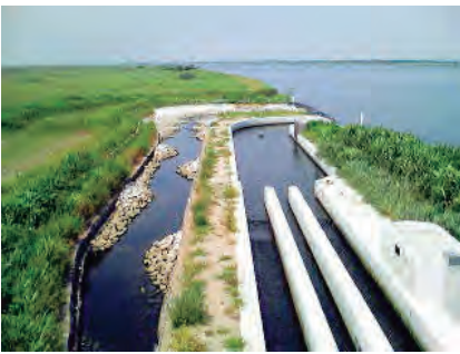
右岸魚道全景 (左は多自然型魚道)
