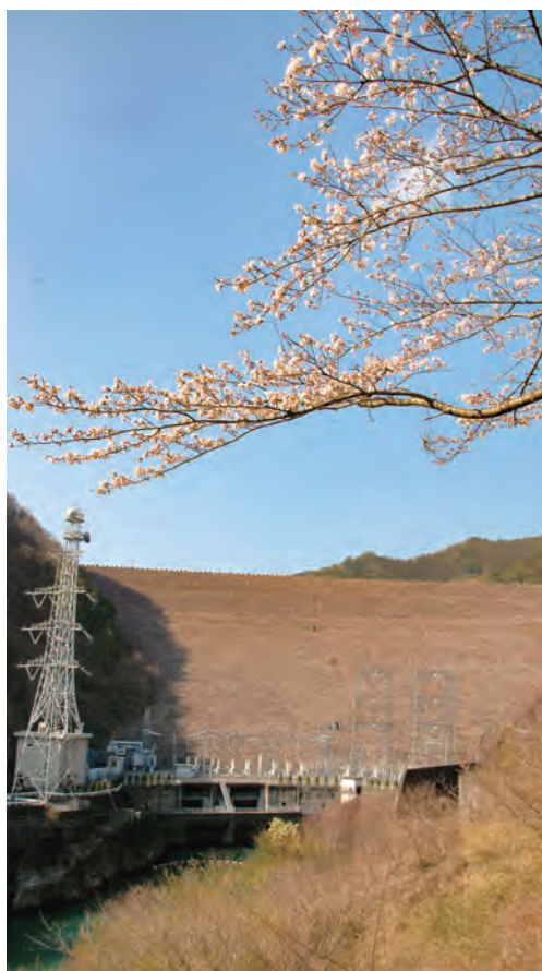
ロックフィルダム堤体 (岩屋ダム)
