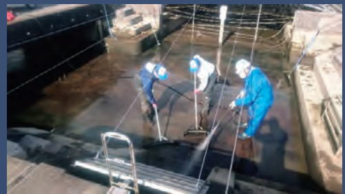
水路清掃の様子
