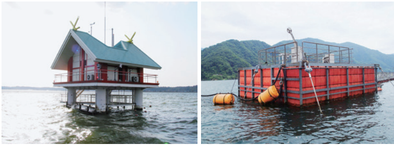
水質自動観測設備 (左：霞ヶ浦開発、右：徳山ダム)
