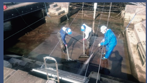
水路清掃の様子
