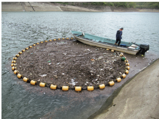
塵芥処理状況（一庫ダム）
