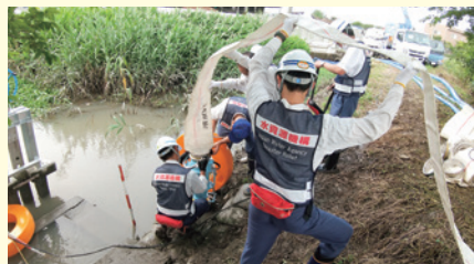
排水ポンプ設置状況
