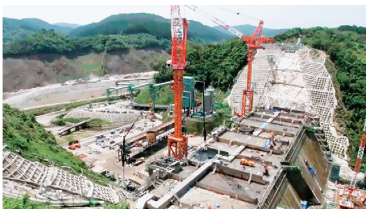
ダム建設工事・コンクリート打設状況（川上ダム）
