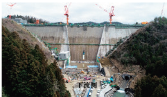
ダム本体工事（川上ダム建設事業）
