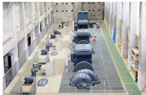
ポンプ設備改修状況 (房総導水路施設緊急改築事業)
