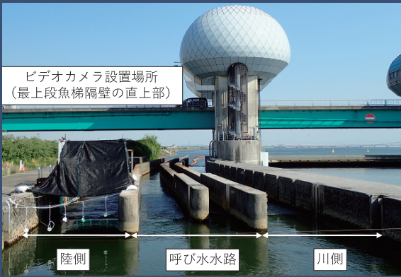
魚道とカメラの設置位置
