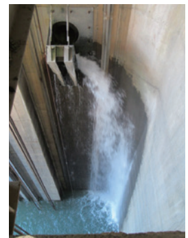
バイパス水路の吐出部
