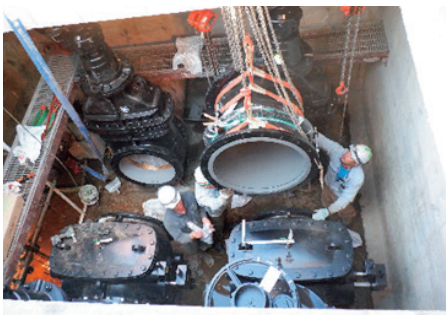
制水弁更新工事 (成田用水施設改築事業)
