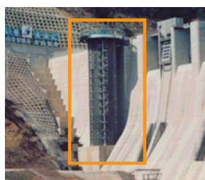
選択取水設備（日吉ダム）
