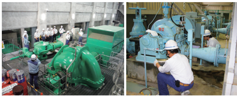
用水供給施設 (左：房総導水路、右：群馬用水)
