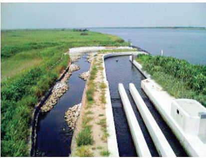
右岸魚道全景 (左は多自然型魚道)
