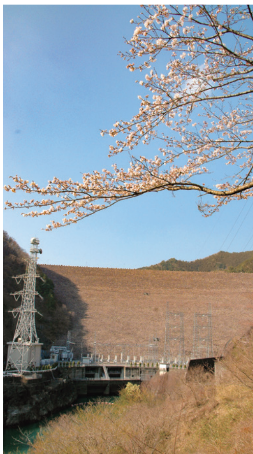
ロックフィルダム堤体 (岩屋ダム)
