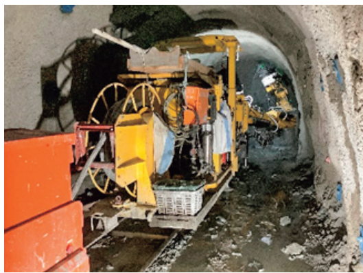
トンネル掘削工事（豊川用水二期事業）
