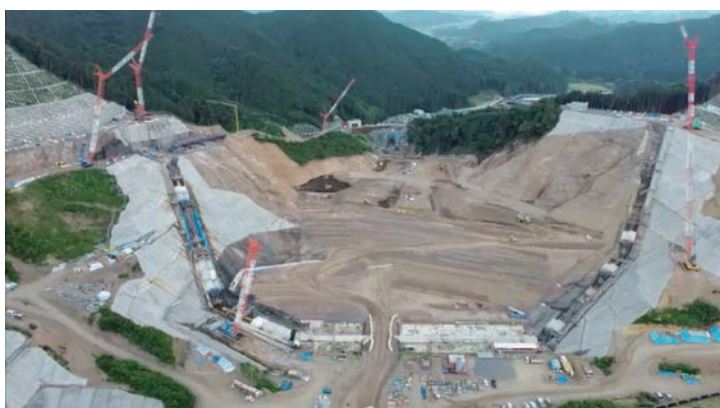
ダム建設工事（思川開発）
