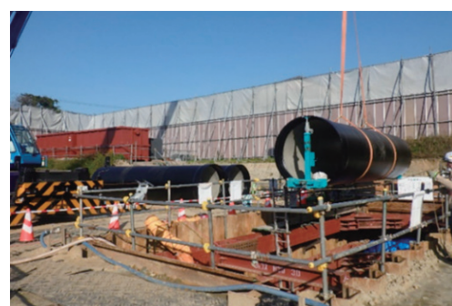
水路改築工事 (香川用水施設緊急対策事業)
