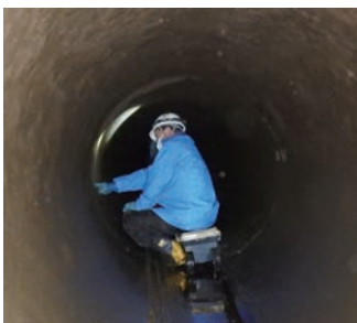
給水管内の点検（北総東部用水）
