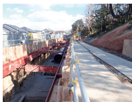
水路改築工事 (愛知用水三好支線水路緊急対策事業)
