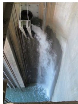
バイパス水路の吐出部
