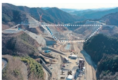
南摩ダム本体工事施工状況 (思川開発事業)
