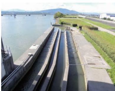
魚道の設置（長良川河口堰）
