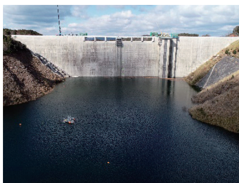
試験湛水中(令和4年1月) (川上ダム建設事業)
