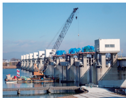
耐震補強工事 (利根導水路大規模地震対策事業)
