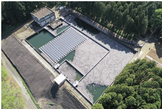
太陽光発電設備と六角フロート （成田用水（高田ファームポンド））※4
