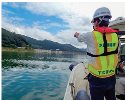
巡視状況（下久保ダム）
