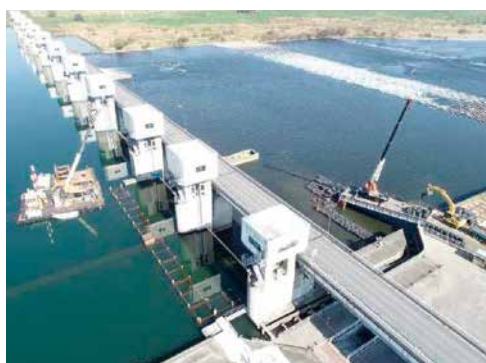
耐震補強工事 (利根導水路大規模地震対策事業)
