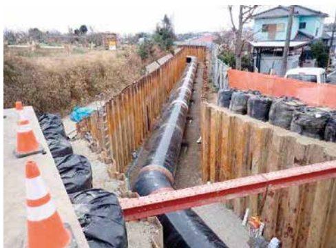
三好支線水路改築工事 (愛知用水三好支線水路緊急対策事業)
