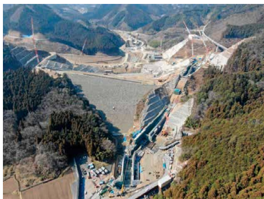
ダム建設工事（思川開発：南摩ダム）
