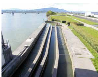
魚道の設置（長良川河口堰）
