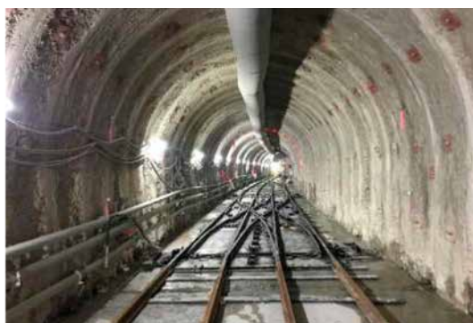
トンネル併設水路工事 (福岡導水施設地震対策事業)
