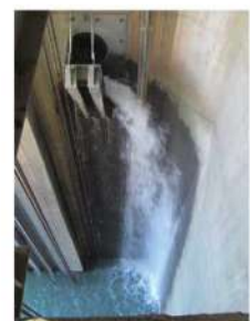
バイパス水路の吐出口
