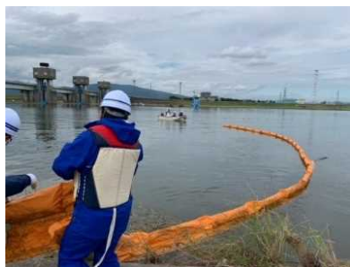
写真 5.6 オイルフェンス設置訓練（筑後大堰）
