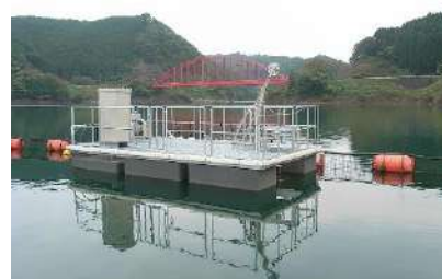
写真 5.3 水質自動観測設備 (青蓮寺ダム)
