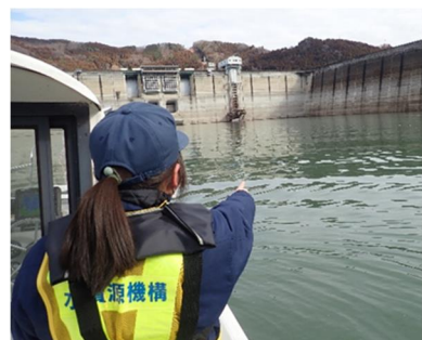
写真 5.1 巡視（下久保ダム）
