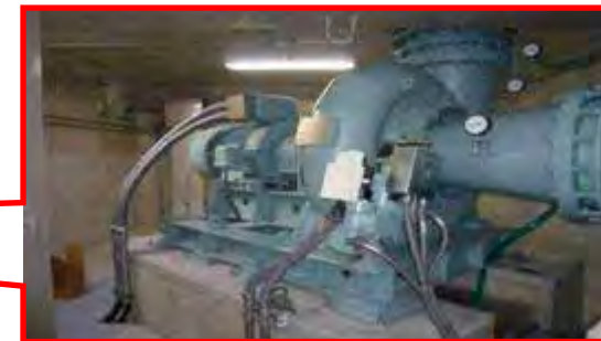
小貝川小水力発電設備
