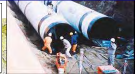
2連管路施工時写真
