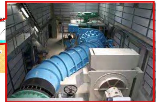
東郷調整池 小水力発電設備
