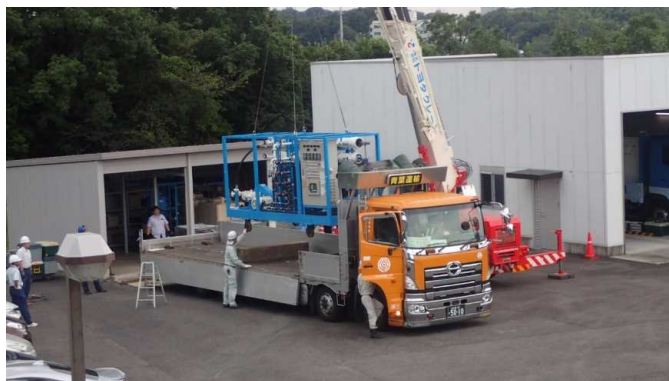
逆浸透膜処理部の積込
