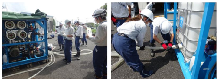
可搬式浄水装置設置訓練の様子
